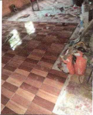
Foto 7. Se observa el proceso de Pegado de piso ceramico
