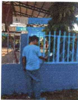
Foto 5. Se observa el proceso de pintura de verjas.
